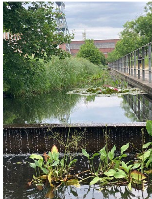
Regenwassermanagement auf dem ehemaligen Zechengelände Ewald
