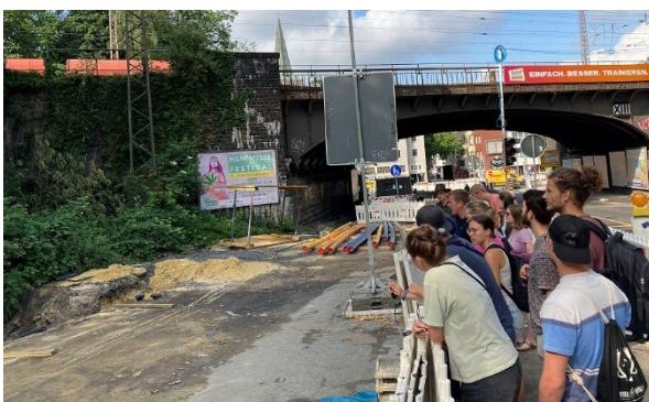
Umbaumaßnahmen an der Castroper Straße
